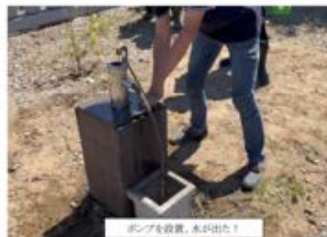
ポンプを設置、水が出た！
