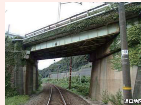
現況（側面全景）
