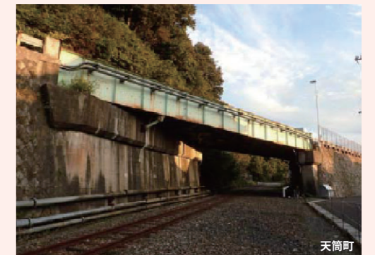
現況（側面全景）
