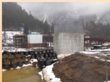
施工状況(P2橋脚)
