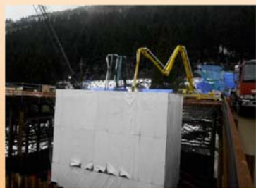
施工状況(P1橋脚)
