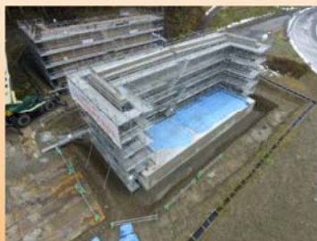
施工状況(和泉IC橋)
