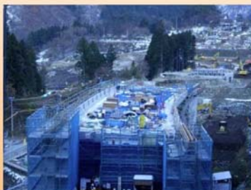
施工状況(白谷川橋)
