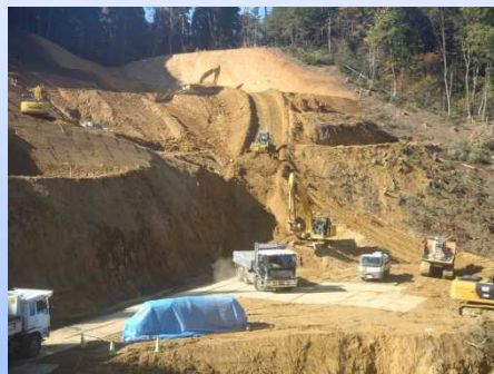
写真-4: 山を切り開いて、土砂を取り除く改良工事を行っています。
