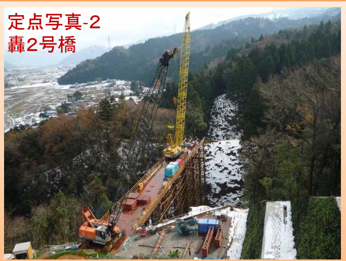
写真-3: 橋梁の上部工事を行っています。
