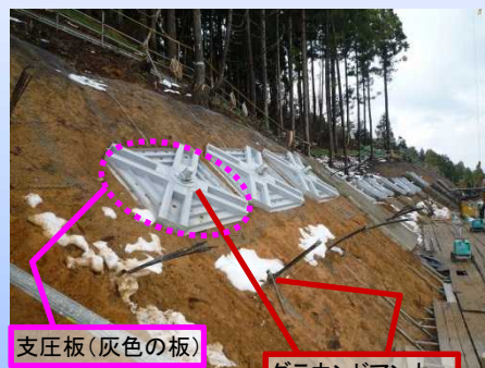
写真-4: 道路のり面の崩壊を防ぐ工事を行っています。
