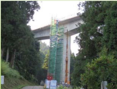
P2橋脚(東側)
