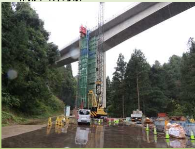
P2橋脚(東側)
