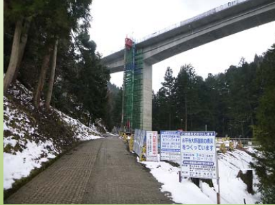
P2橋脚(東側)
