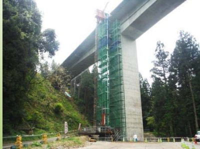
P2橋脚(東側)
