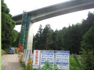
P2橋脚(東側)
