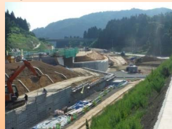
補強土壁施工状況
