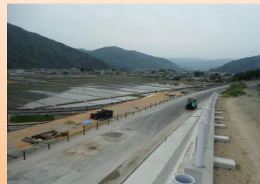
施工状況(浅見地区)
