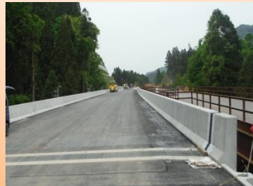
施工状況(轟地区)
