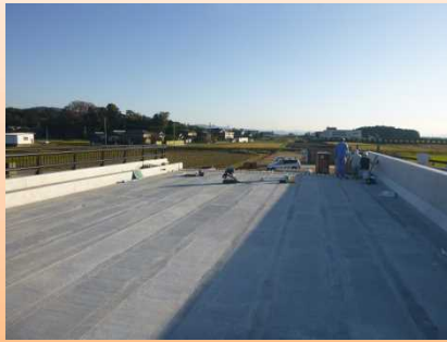
写真-③:熊坂川橋(仮称)東側
