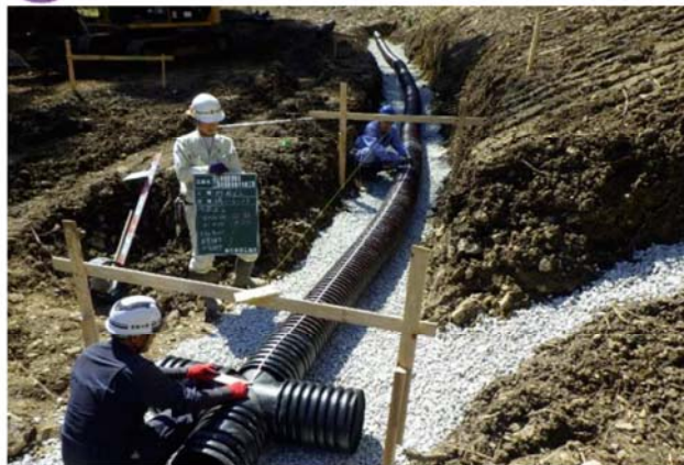
4 排水管設置工事を推進しています。
