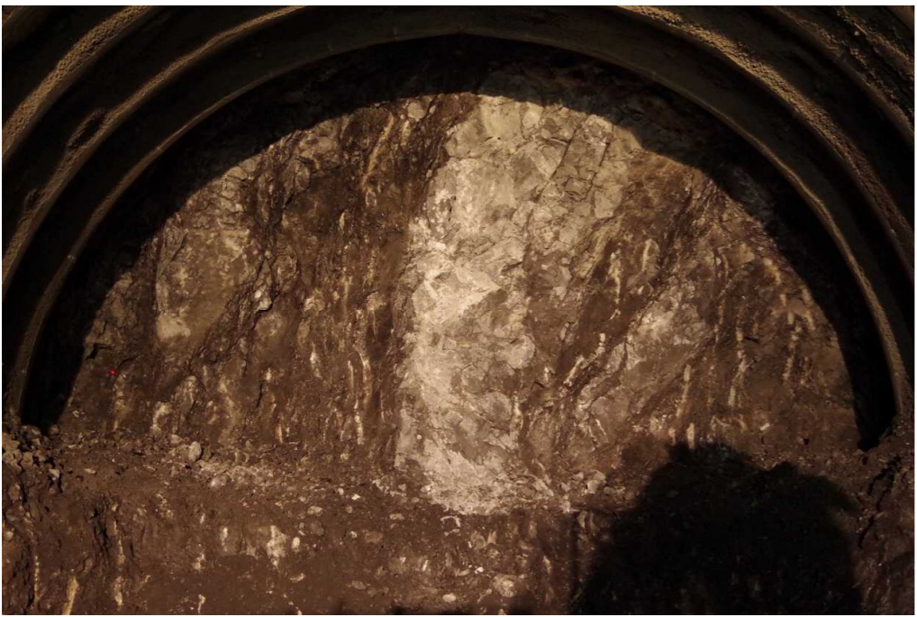
※冠山峠2号トンネル(仮称)は、平成26年6月30日から掘削に着手しました。
