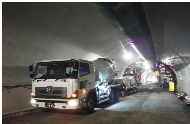
覆工コンクリートの施工状況 (H29.5.31 撮影)
