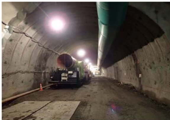
吹付の状況 (H30.6.30 撮影)
