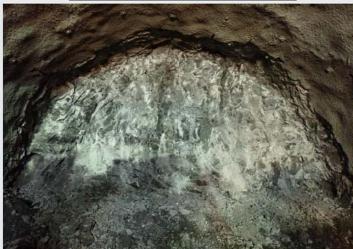
※冠山峠2号トンネル(仮称)は、平成26年6月30日、掘削に着手しました
