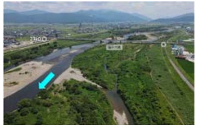
図 1.3.10 樹木繁茂状況 (九頭竜川 23k 付近)
