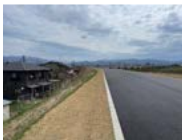
図 6.2.3 堤防天端の舗装
