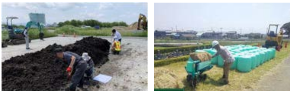
図 6.2.1 刈草のリサイクル状況（堆肥化・ロール化によるコスト削減）
