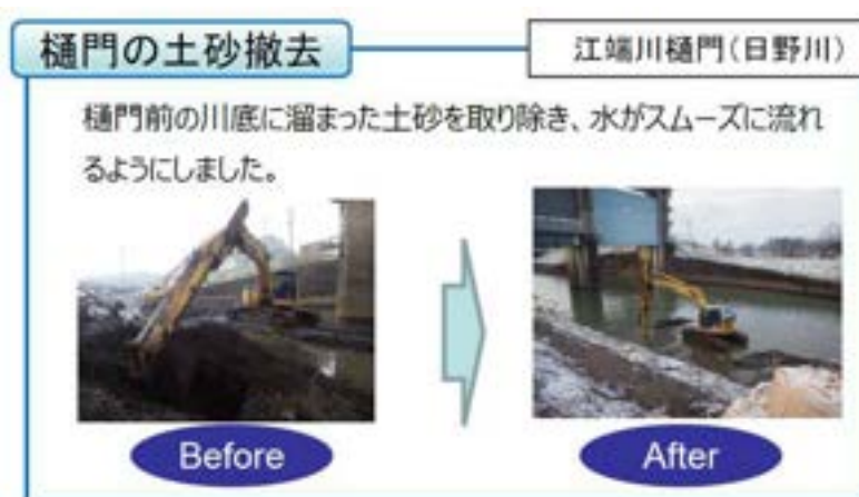
図 6.1.2 維持掘削状況
