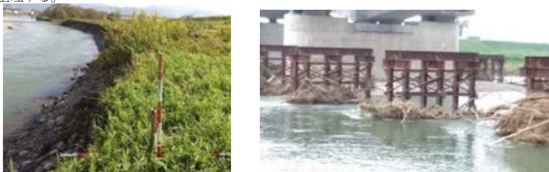
図 5.4.2 出水後の点検（河岸の崩落および流木等の堆積）
