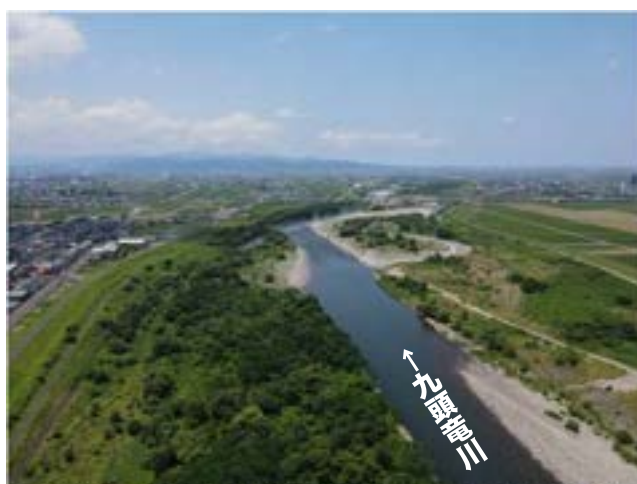
図 1.3.166 河道内樹木の繁茂状況（九頭竜川 26k 付近）
