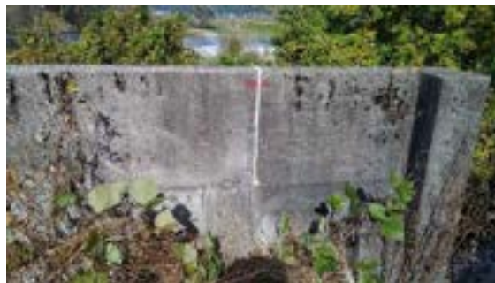
図 6.2.4 特殊堤の補修
