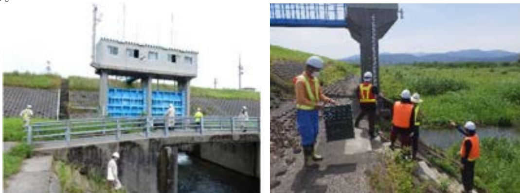
図 5.4.1 河川管理施設（樋門）の点検
