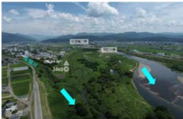
図 1.3.9 九頭竜川河道拡幅部 (25k 付近)
