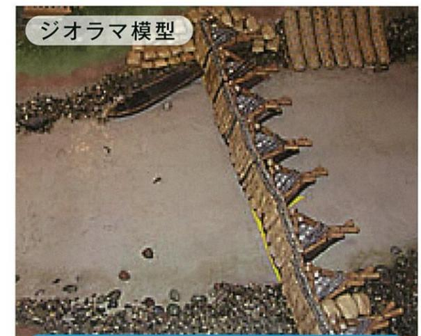
伝統的な河川構造物とし、洪水時に水の勢いを弱め、堤防の破壊を防いだり、川を締め切り取水堰の役割を目的としたものの一つで、丸太を三角すいや紡(ぼう)水の形にくんだものです。
