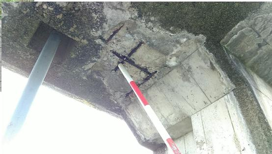
樋門ゲートの老朽化(片川放水路樋門4号ゲートの腐食)
