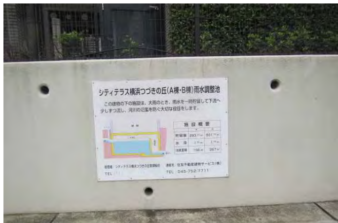
地下貯留施設を示す看板の例
