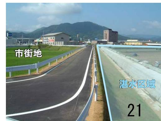
二線堤整備状況
