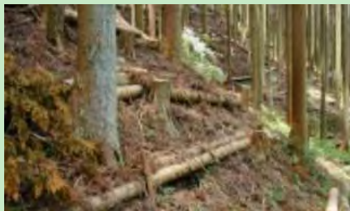
間伐材を利用した土留工の設置例
