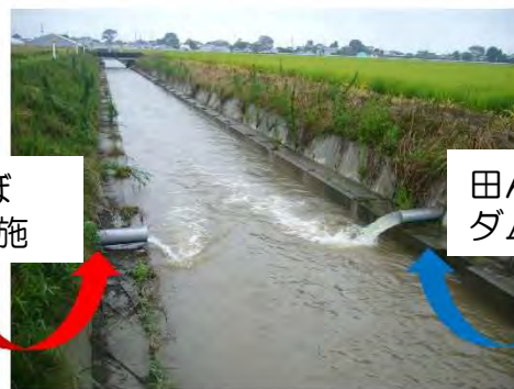
排水状況の比較 平成23年7月新潟・福島豪雨 白根郷地区(新潟市)
