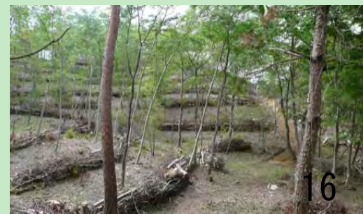
過密林の伐採後に土留工を設置
