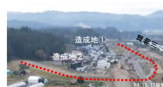
移転家屋の建設が進む状況
