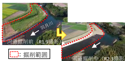
河道掘削(鹿児島県内川水系羽月川)
