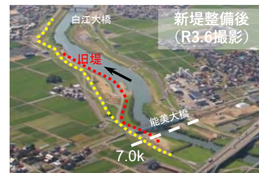
引堤(石川県梯川水系梯川)
