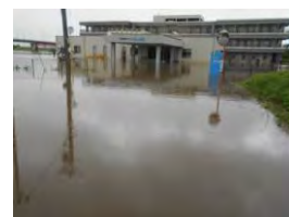
浸水時の状況 (喜多方市提供)
