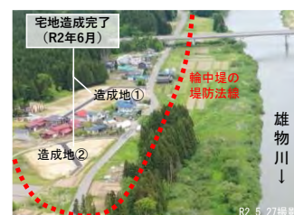
移転先宅地造成完了状況
