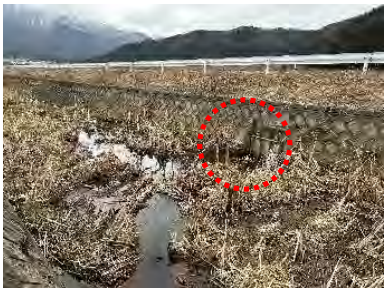
フラップゲートが埋没しており機能していない
