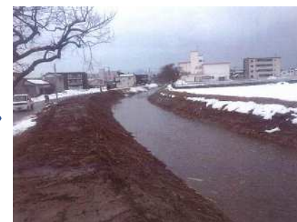
小松川浚渫後
