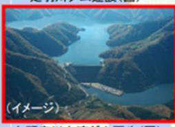
九頭竜川上流ダム再生（国）
