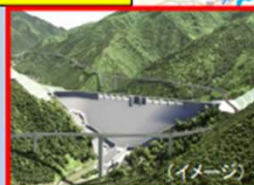
足羽川ダム建設（国）
