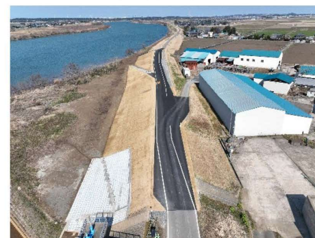
定広地区 堤防拡築工事（令和6年3月撮影）
