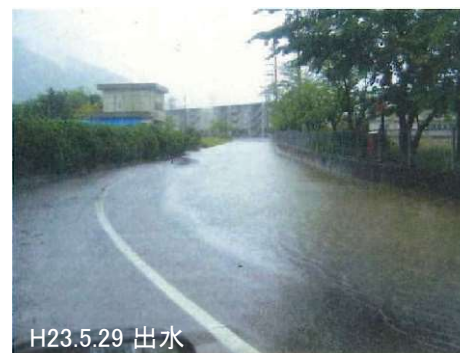
2号排水路付近
