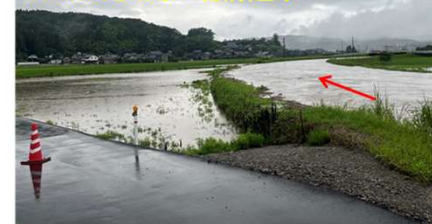
R5.7.13(大雨) 堤防越水
