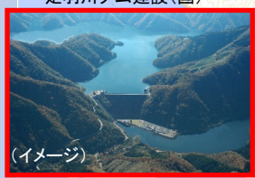
九頭竜川上流ダム再生（国）
