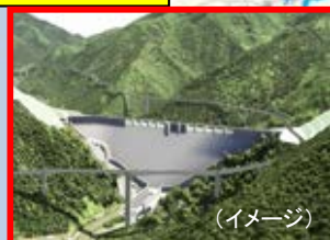
足羽川ダム建設(国)
