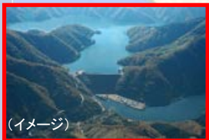
九頭竜川上流ダム再生(国)
