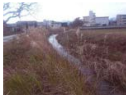
小松川浚渫前
