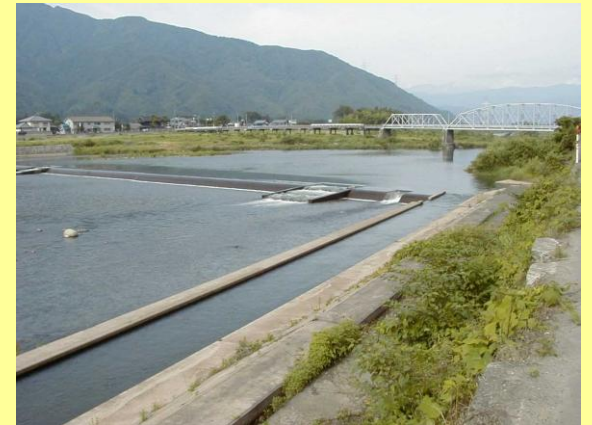
小舟渡取水堰(永平寺町藤巻付近)
