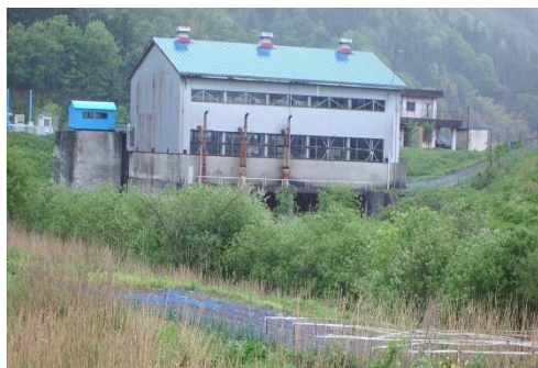
狐川排水機場
