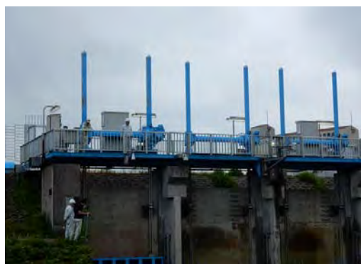
狐川樋門点検の実施状況（H29. 5. 25）
