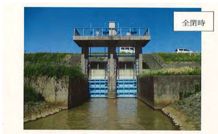
九頭竜川排水樋門 （平成29年5月 点検）
