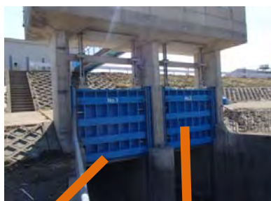
戸当損傷、塗装劣化
