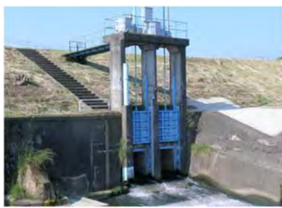
旧馬渡川樋門
