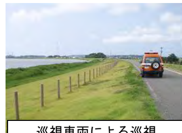
巡視車両による巡視
