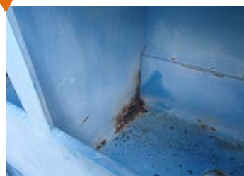
戸当損傷、塗装劣化
