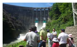
ダム見学会実施状況
