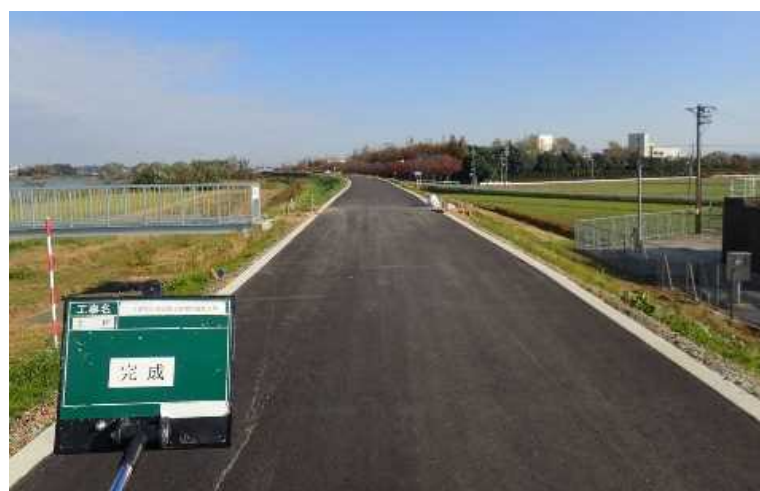
天端保護箇所(池見地区)
