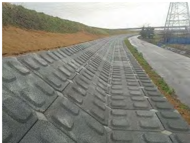
堤防裏法尻補強（高屋地区）
