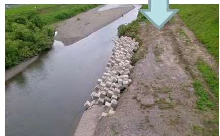
土砂で埋め戻した後、 根固ブロックで浸食 防止措置を行った。
