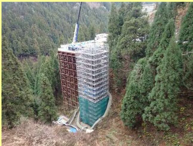
付替県道7号橋工事 (H30.12)
