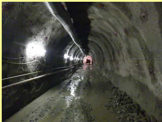
足羽川ダム転流工事 (H30.12)
