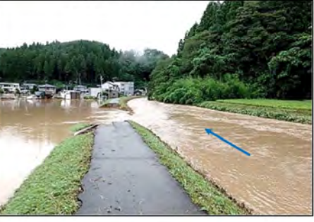
志津川 6.0k 付近（福井市大森町付近） 令和3年7月29日 出水
