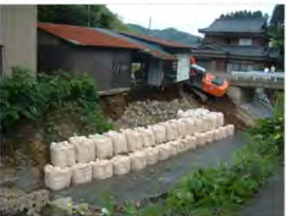
越知川 応急復旧（越前町上糸生）
