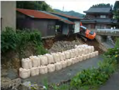
越知川 応急復旧（越前町上糸生）
