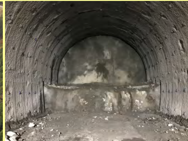
水海川導水トンネル 2期工事(R5.11)
