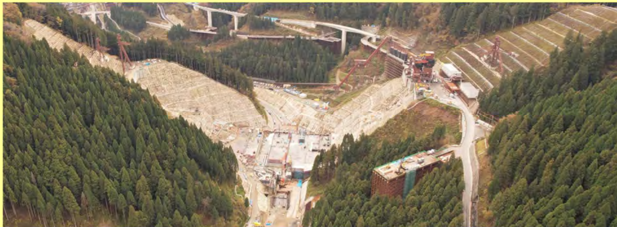
足羽川ダム本体建設(第1期)工事(R5.11)
