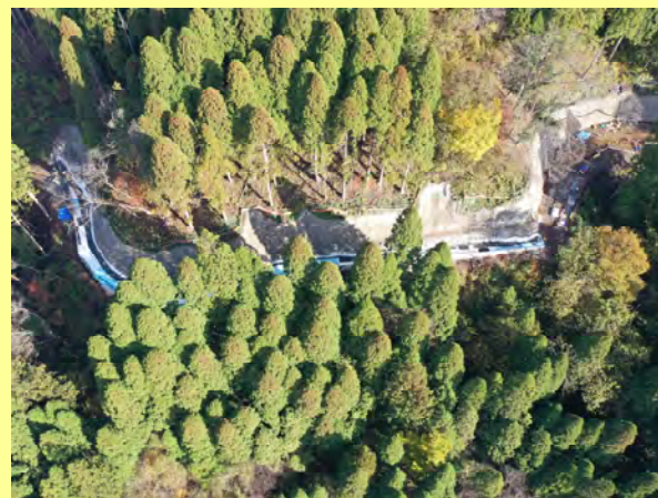
付替町道下荒谷線 改良工事(R5.11)
