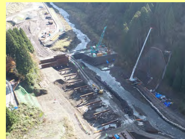
水海川貯砂ダム工事(R5.11)
