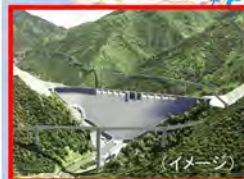
足羽川ダム建設（国）
