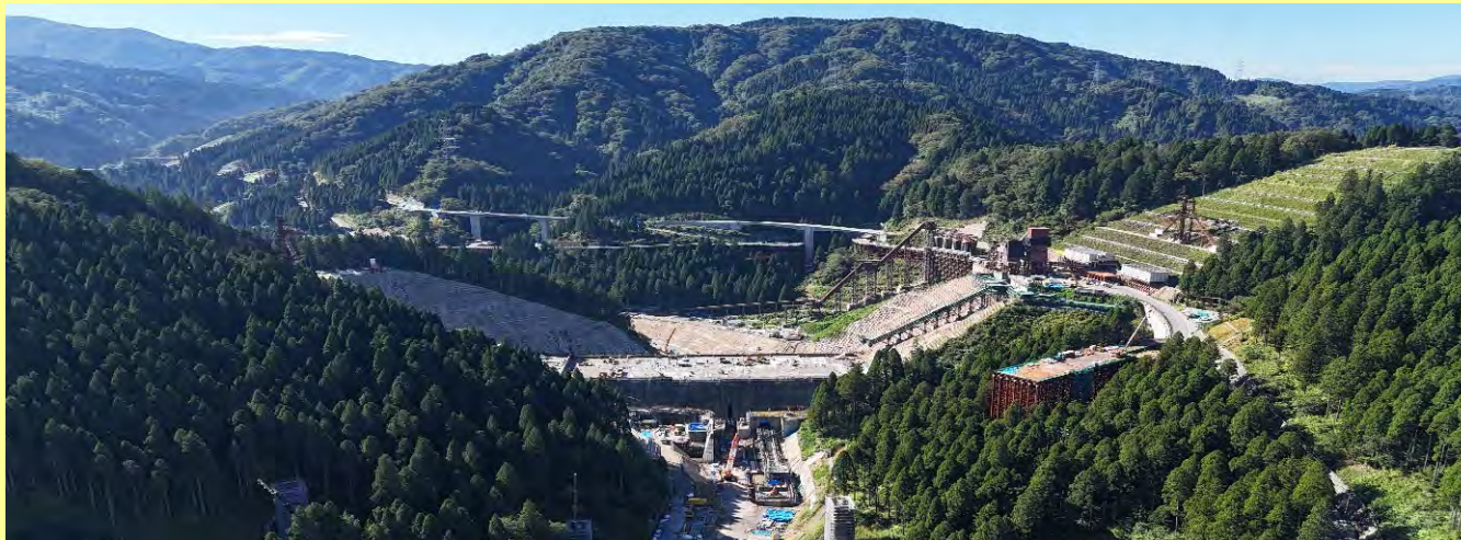
足羽川ダム本体建設(第2期)工事(R6.9)
