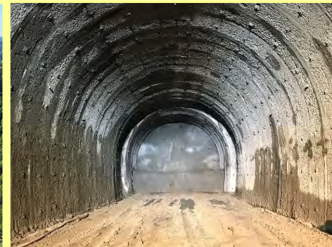
水海川導水トンネル 3期工事(R6.9)
