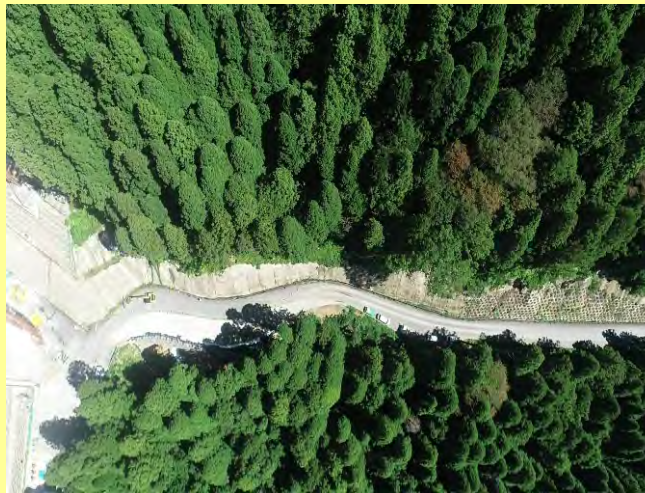
付替町道下荒谷線下流 工区改良工事(R6.9)
