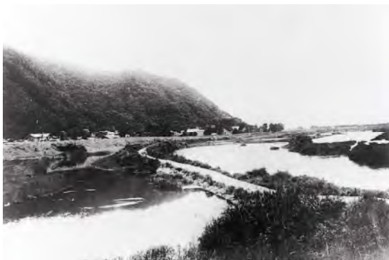
改修工事前の亀の甲付近
