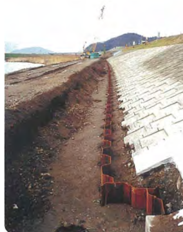
写真 1.2.7 漏水対策工事実施状況
