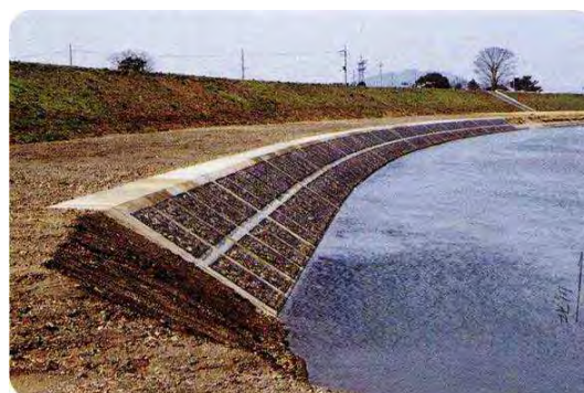
府中地区護岸工事後
