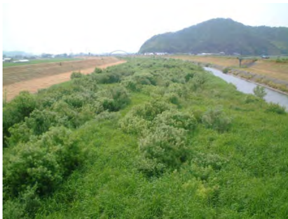
河道内樹木の繁茂
