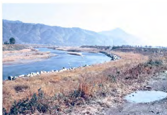
昭和 47 年の左岸 2.0km より上流を望む
