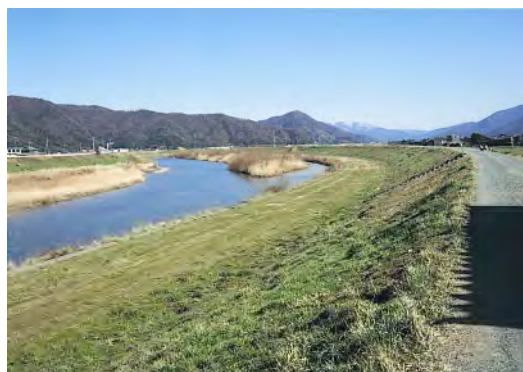
平成 15 年の左岸 2.0km より上流を望む
