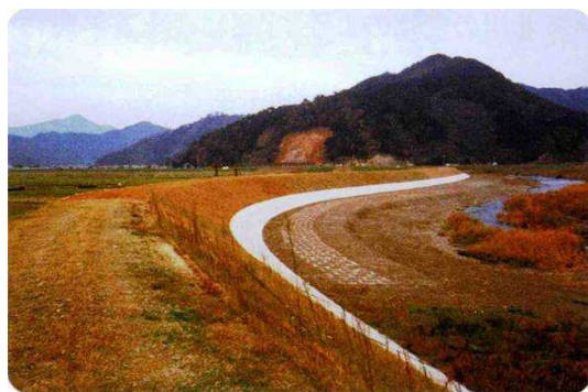
遠敷川左岸築堤・護岸工事後
