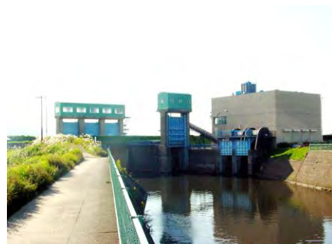
礪部川 排水機場と逆流防止水門 （坂井市春江町安沢）
