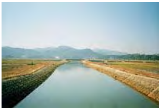
片川 放水路（福井市波寄町）
