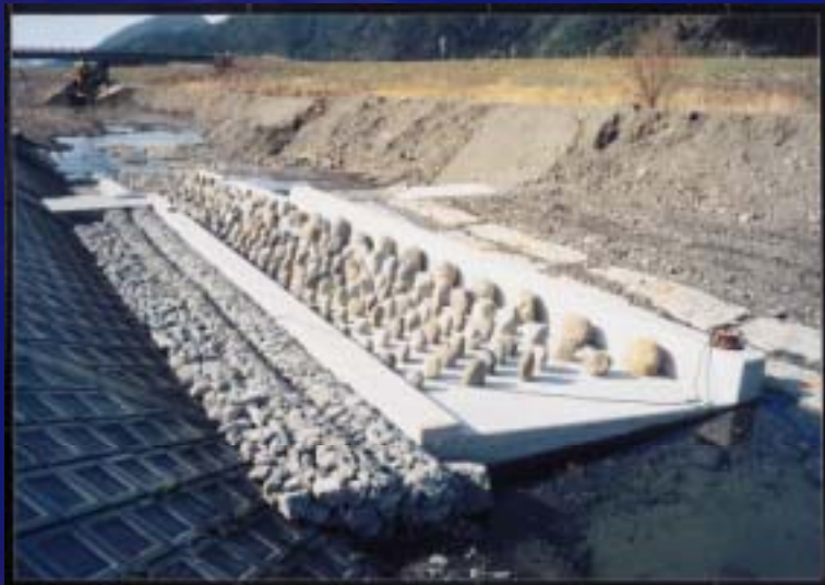
浮石付き魚道の施工状況
