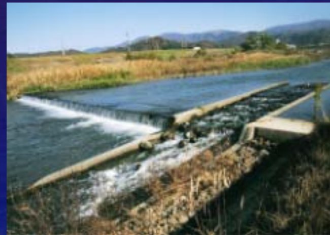
成之部床固工の魚道
