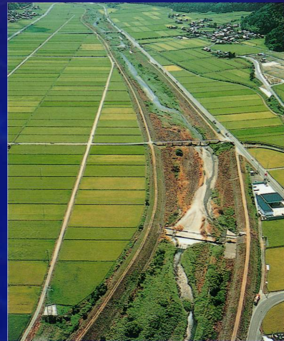
◇三宅橋付近の状況 (H6. 8. 10)
