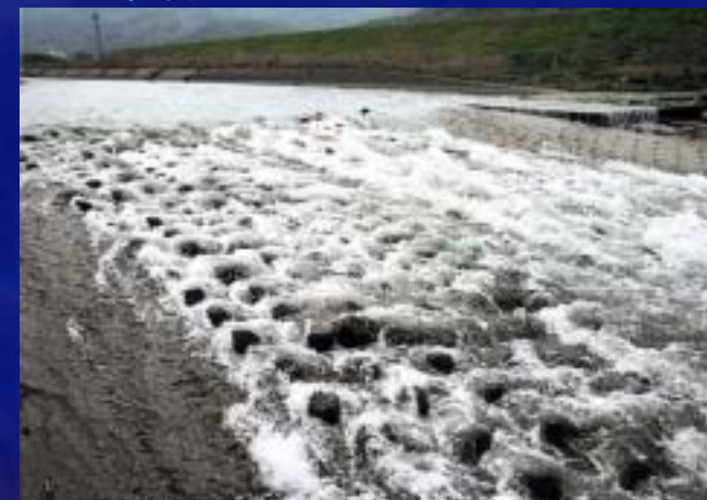
孫城床固工の全面魚道
