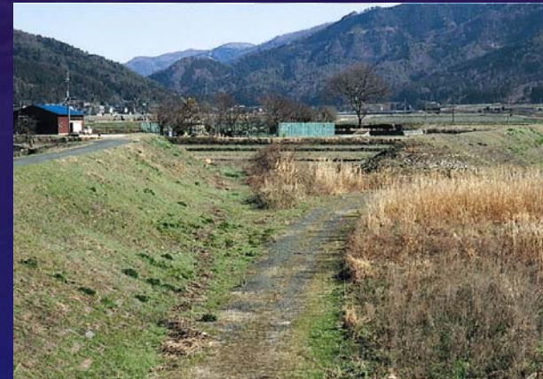
(北川右岸12.6K付近の霞堤)
