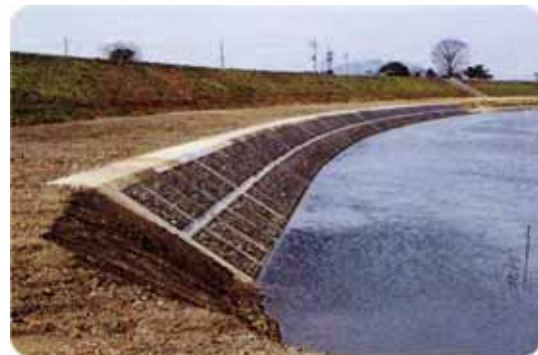
府中地区護岸工事後
