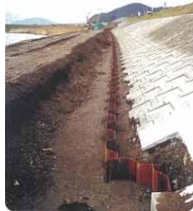
写真 1.2.7 漏水対策工事実施状況
