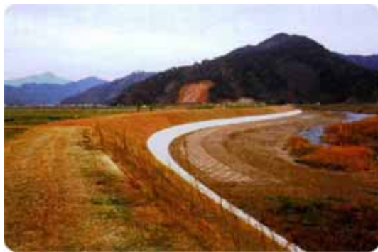
遠敷川左岸築堤・護岸工事後
