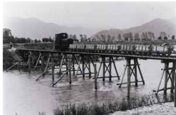
北川・江古川に架橋して築堤用の土砂を運搬する機関車
