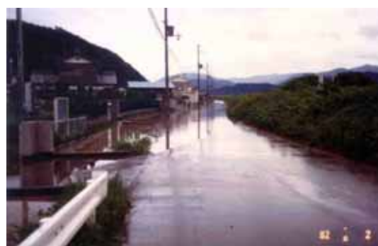
昭和57年8月台風10号 小浜市水取地区(右岸0.6k付近)の浸水状況
