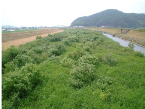
河道内樹木の繁茂
