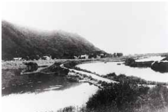
改修工事前の亀の甲付近
