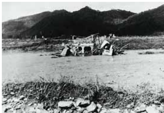
昭和28年9月台風13号 流出した丸山橋
