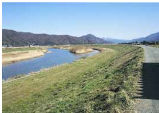
平成15年の左岸2.0kmより上流を望む
