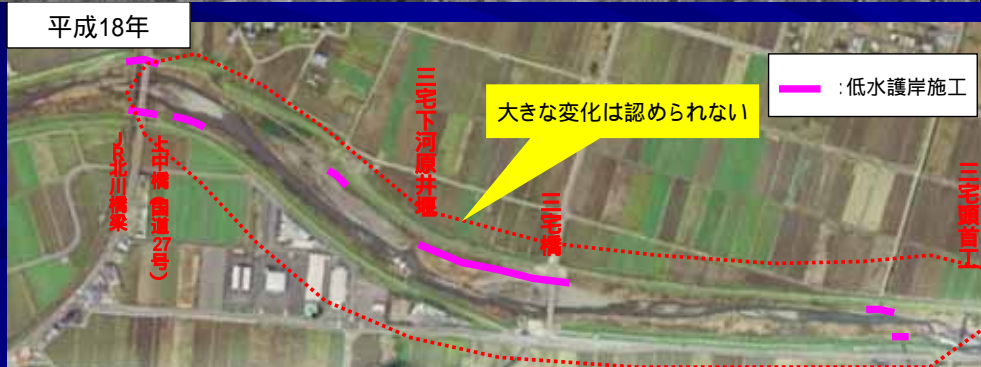
低水護岸施工削前後の比較 (JR上中橋梁～三宅頭首工付近)
