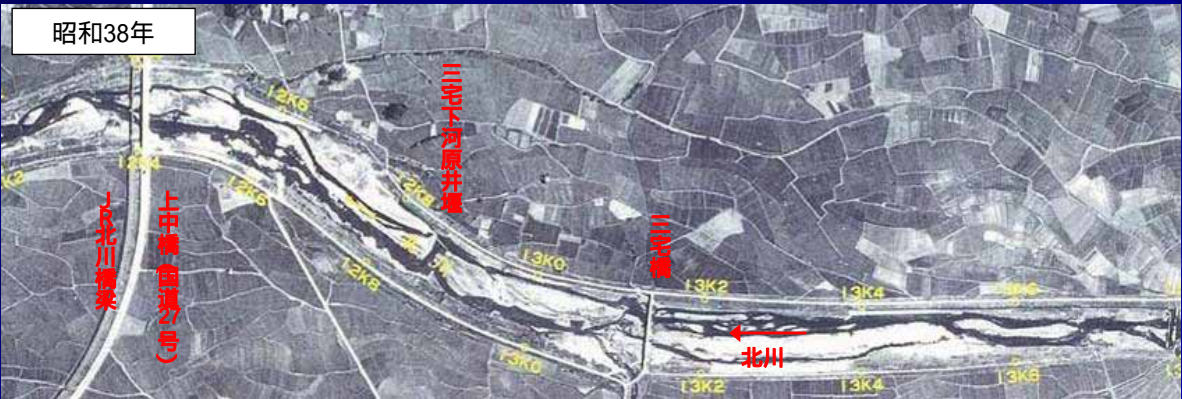
JR上中橋梁～三宅頭首工付近の航空写真(1)
