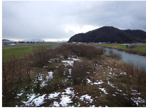
北川左岸2.1k付近～2.4k（府中橋下流）
