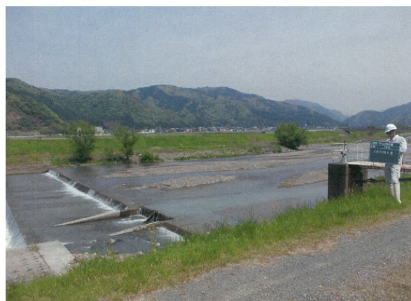
三宅下河原井堰（H27. 4. 28 点検）
