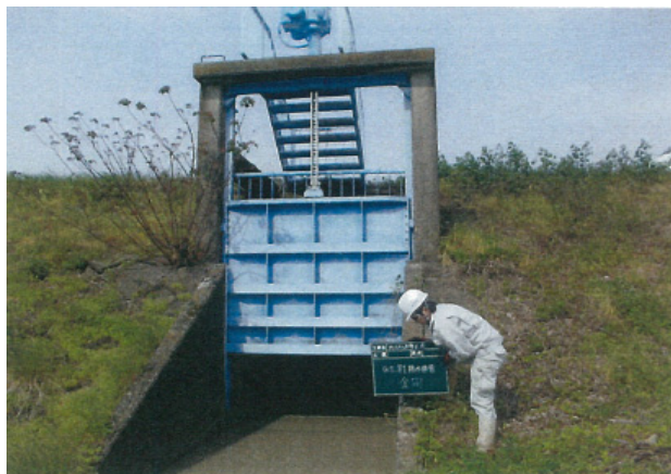
瓜生第一排水樋門（H27. 4. 28 点検）
