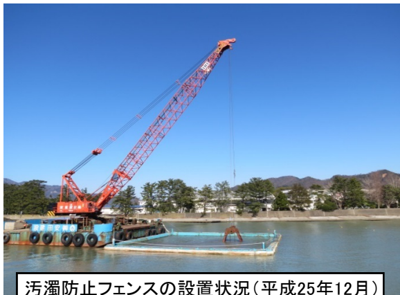
汚濁防止フェンスの設置状況（平成25年12月）
