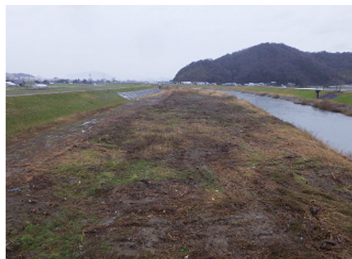
北川左岸2.1k付近～2.4k（府中橋下流）
