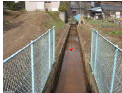
流入水路の状況
