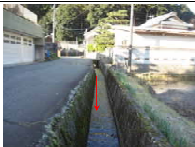
流入水路の状況
