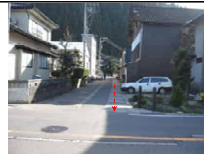
流入水路の状況
