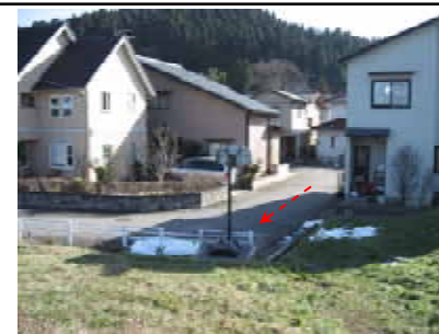
流入水路の状況
