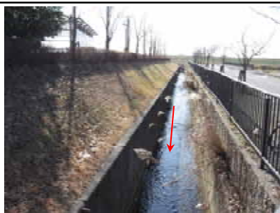
流入水路の状況
