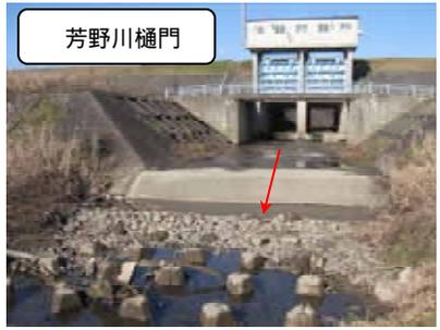
芳野川樋門 | 落差の解消<br>水深の確保<br>多様な魚種遡上・降下 | 水路への集水等による水深確保<br>プールタイプ魚道の設置<br><br>プールタイプのイメージ図(案)<br>(ハーフコーン型魚道)<br><br>
