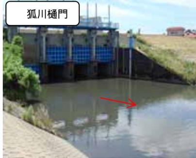
狐川樋門         | 水深の確保<br>多様な魚種遡上・降下          | 水路への集水等による水深確保<br>ストリームタイプ魚道の設置<br><br>ストリームタイプのイメージ図(案)<br>(粗石付斜曲面魚道)<br><br>
