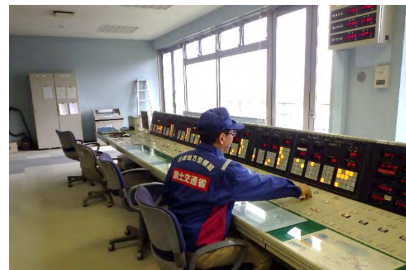
堰の操作システムの点検の様子
