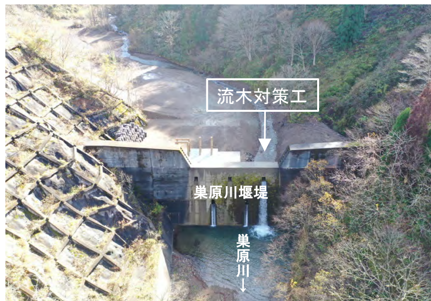
巢原川堰堤改築(令和5年12月時点)
