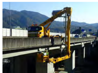
橋梁点検車を用いた点検状況
