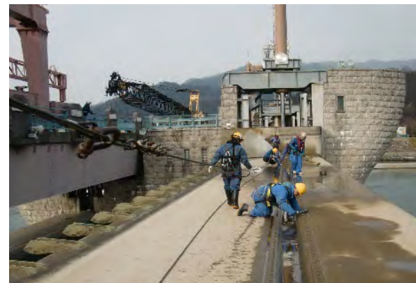
主ゲート扉体点検の様子
