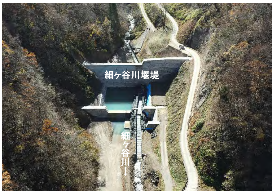
細ヶ谷川堰堤(令和5年12月時点)
