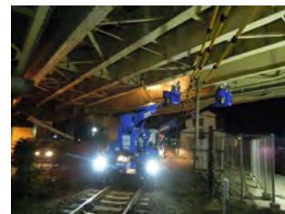
橋梁点検状況(鉄道を跨ぐ橋梁部)
