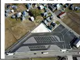
白崎チェーン着脱場 (R2.3完成) 駐車台数 大型車11台
