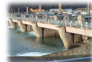
九頭竜川鳴鹿大堰
