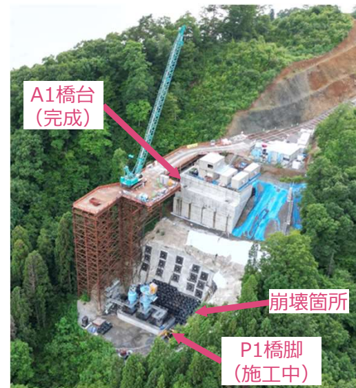
写真1 下部工事の状況
