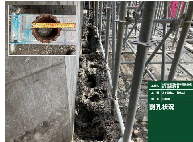
写真2 削孔した穴の状況
