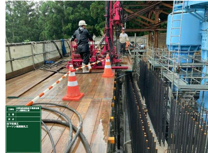
写真1 沈下不能対策工事（削孔）の状況
