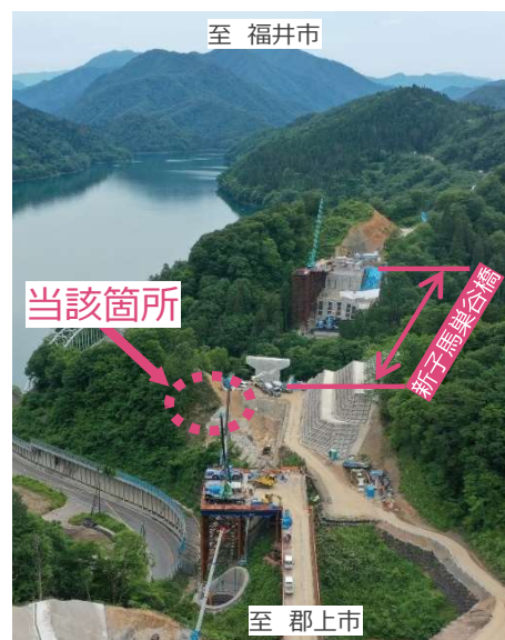
写真1 上部工事の状況
