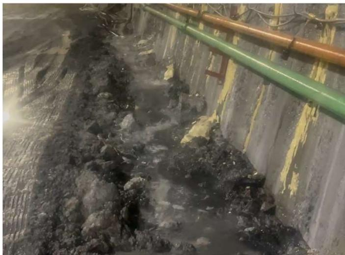
■ 写真1 トンネル抗内に流れるの湧水状況（大谷トンネル）
