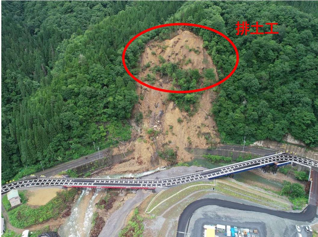
写真1. 応急的な措置（排土工）
