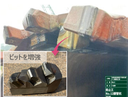
写真6 鋼管杭先端のビット
