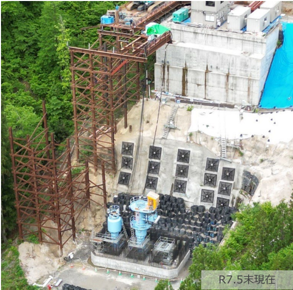
写真2 仮橋撤去・補強後の状況
