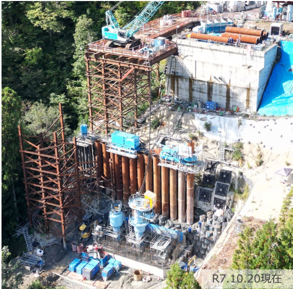
写真3 抑止杭の施工状況
